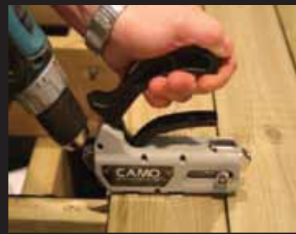
Skruva ned skruvarna
